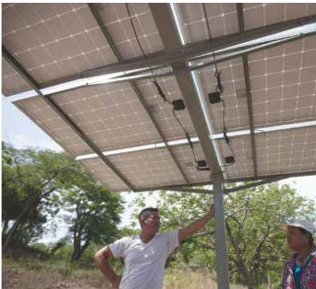
▲ En La Flor, cerca de Somotillo, la escasez de agua debido a la persistente sequía sigue causando grandes dificultades a las personas que viven allí. Se ha perforado un pozo profundo y se ha instalado una bomba de energía solar para bombear agua desde unos 45 m de profundidad. Dicha agua proporciona a los vecinos el agua para beber y lavar. FOTO: SEAN HAWKEY/ACT
